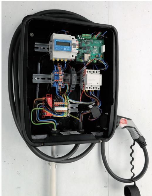
Bild 10: Wallbox mit integrierter Überspannungsschutzeinrichtung Typ 2 + Typ 3
